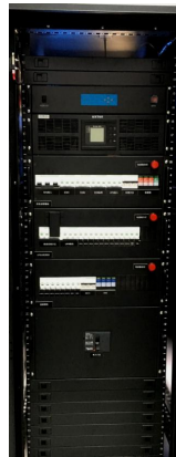
一体化配电柜
